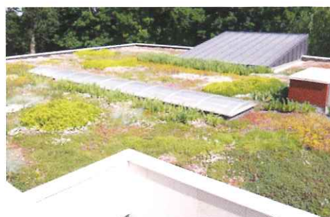
Toiture terrasse végétalisée
