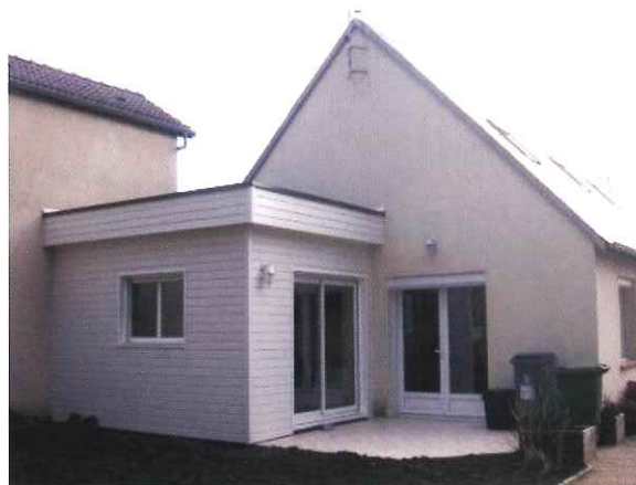
Toit terrasse en volume de liaison
